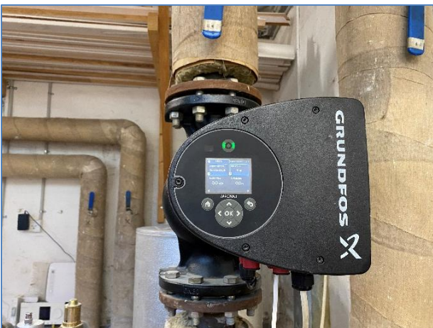
Foto 5: Cirkulationspumpe
