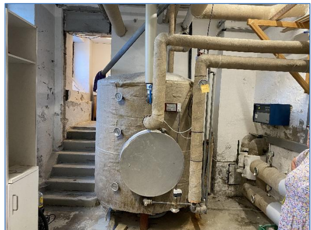
Foto 6: Varmtvandsbeholder fra 1996
