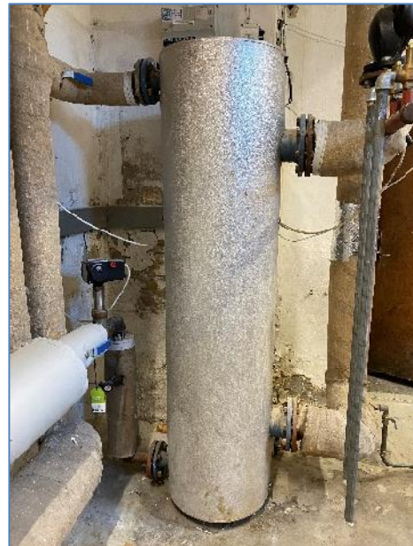
Foto 4: Rør veksler
