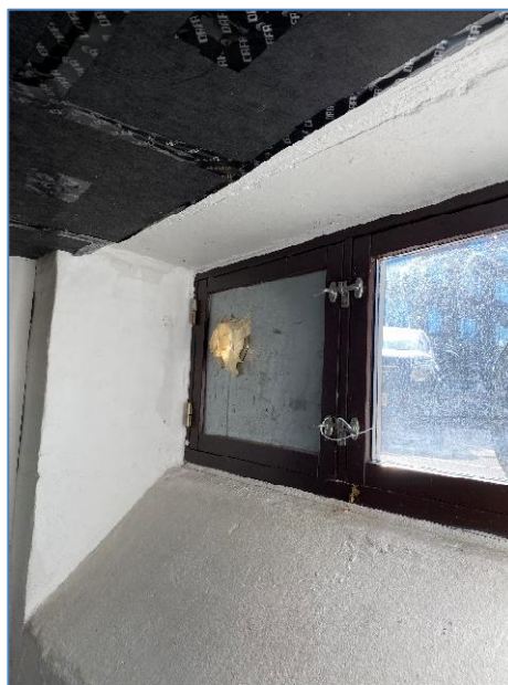
Foto 4: Gammelt afkast i vindue
