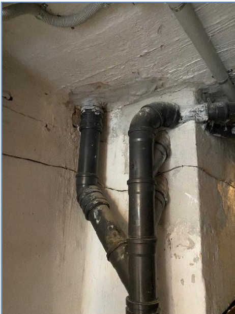
Foto 3: Faldstamme i kælder
