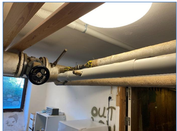
Foto 6: Varmør i kælder
