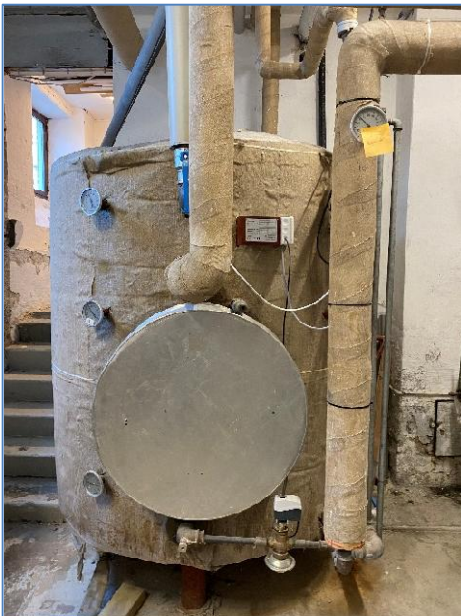
Foto 3: varmtvandsbeholder fra 1996
